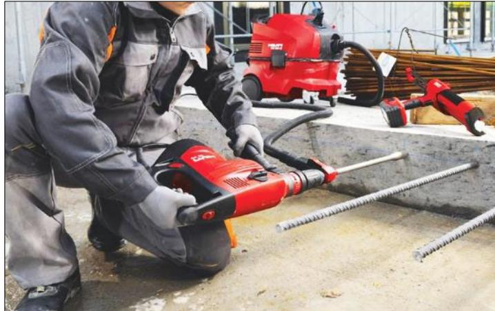
PERFURAÇÃO EM CONCRETO E FIXAÇÃO DE ARMADURA COM ADESIVO
