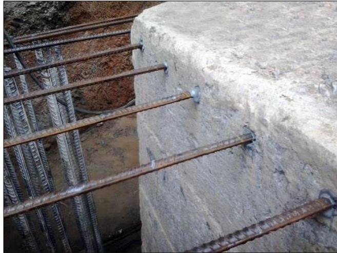
EXEMPLO DE ANCORAGEM – PERFURAÇÃO EM CONCRETO E FIXAÇÃO DE ARMADURA COM ADESIVO
