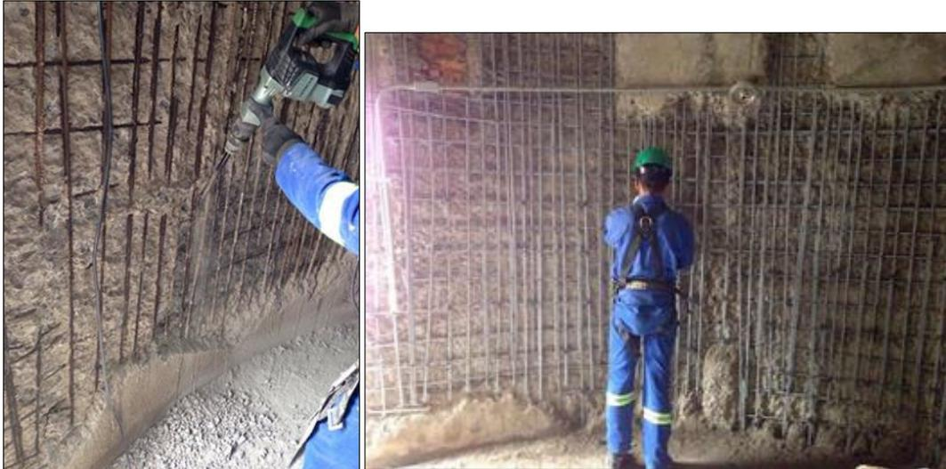
PREPARO DA SUPERFÍCIE PARA PONTE DE ADERÊNCIA – ARMADURA DE REFORÇO E GRAUTEAMENTO
