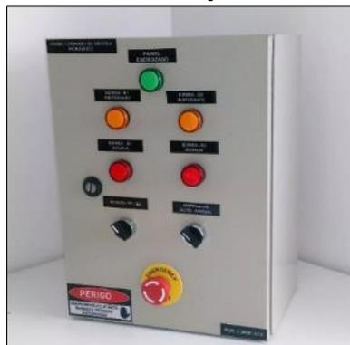
**PAINEL DE COMANDO PARA 2 BOMBAS DE ESGOTO**
